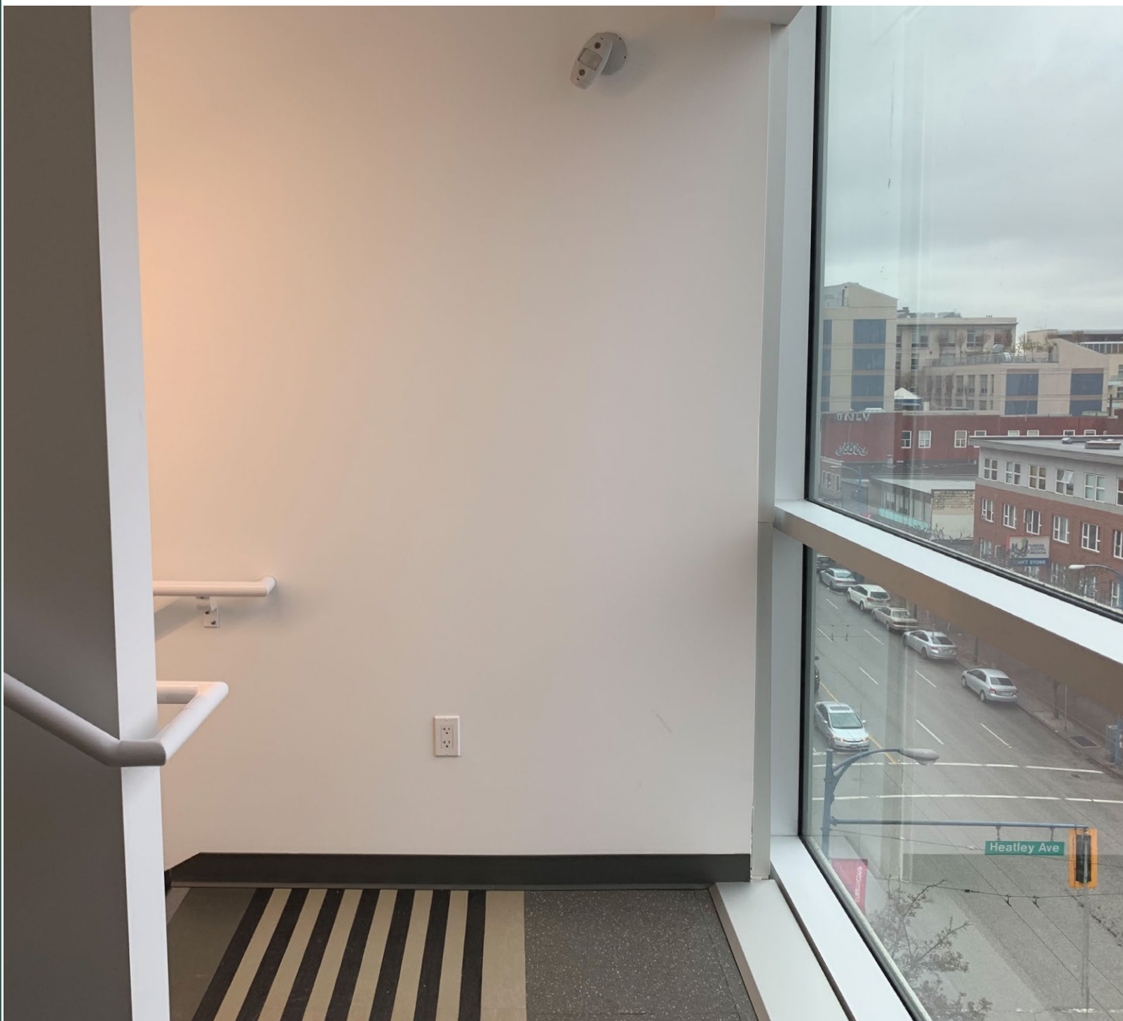
Figure 14: Fenêtres découpées et lumière substantielle dans les escaliers communs du bâtiment Cause We Care de YWCA
