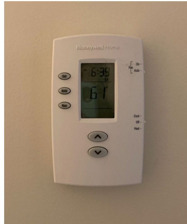
Figure 20: Contrôle de la température dans un logement, My Sister's Place, Prince George
